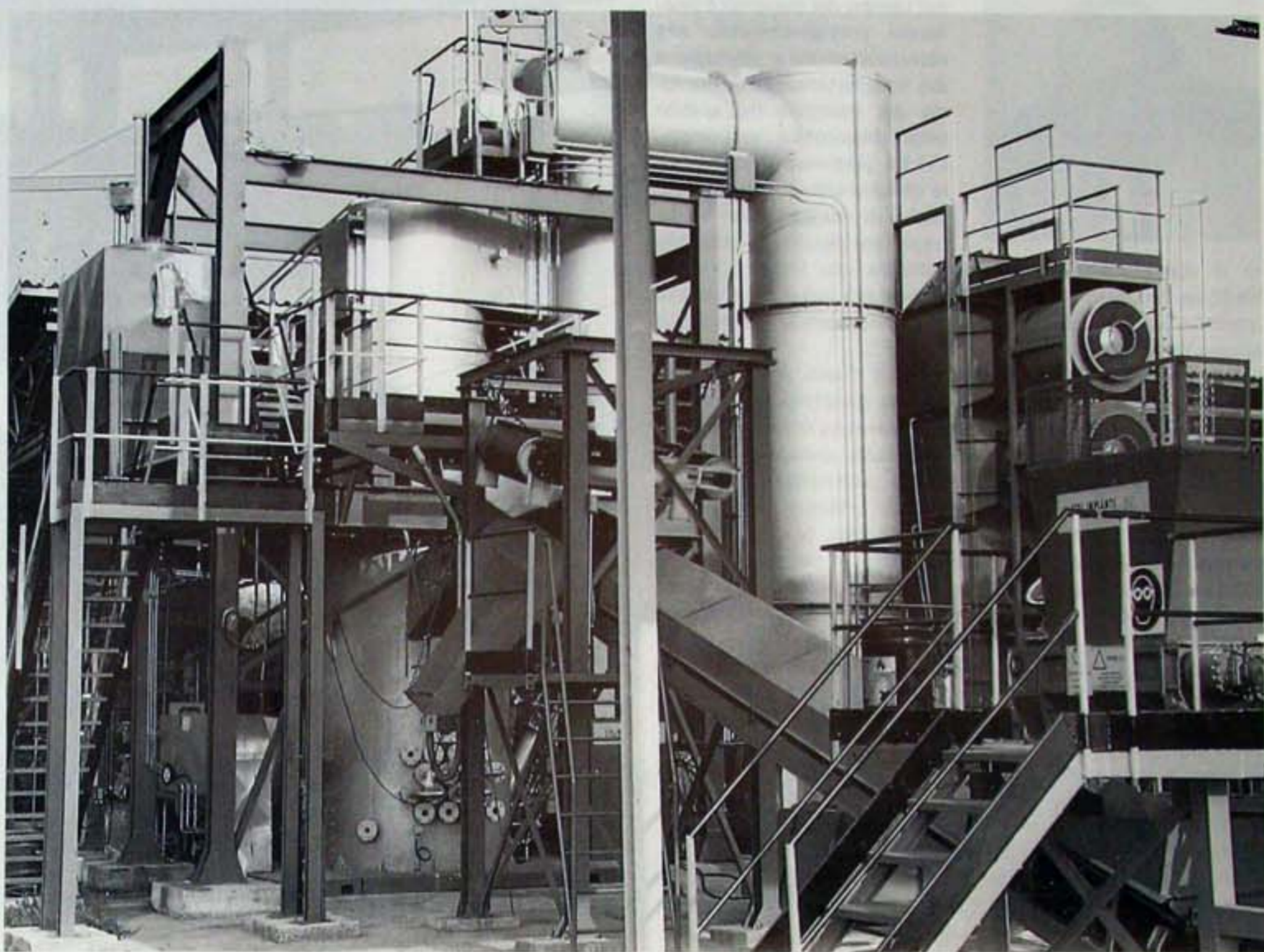
L'impianto sperimentale di incenerimento a letto fluido, realizzato dall'Italimpianti a Busto Arsizio.
